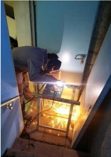
*Abbildung 8-15: Plasmaschneiden der Bohrungen*
